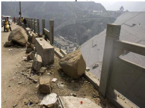
Рис. 4. Фрагменты повреждения плотины «Зипингпу» во время землетрясения [9]
